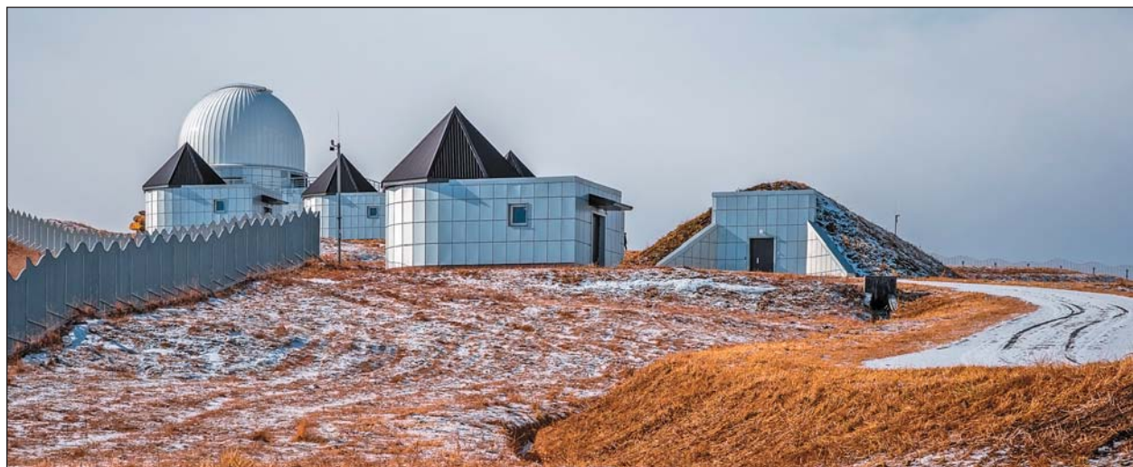
Вид на верхнюю зону обсерватории: башня 2.5-метрового телескопа, четыре малых павильона с временными укрытиями и гравиметрическая лаборатория.
